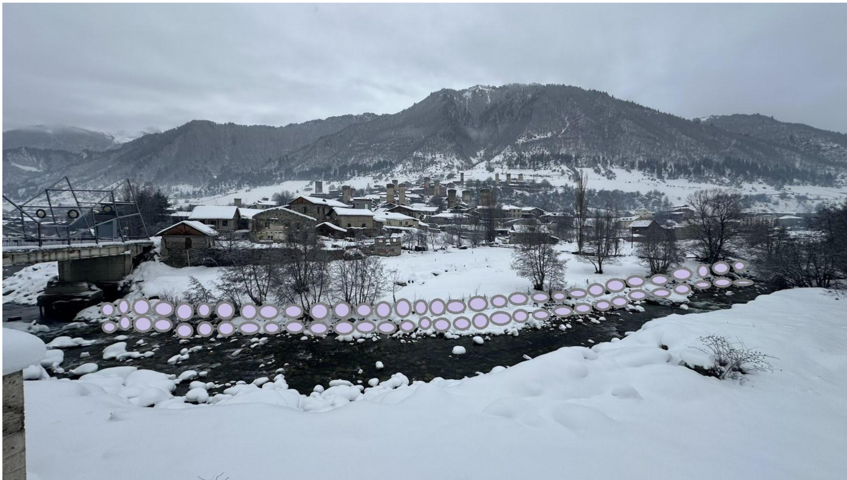
ფიგურა 5.2 მარჯვენა სანაპიროს პირველი სექციის ვიზუალიზაცია, სადაც დაგეგმილია SCS-4.1 ფლეთილი ლოდები ხრემის სამირკველით/საგებით
