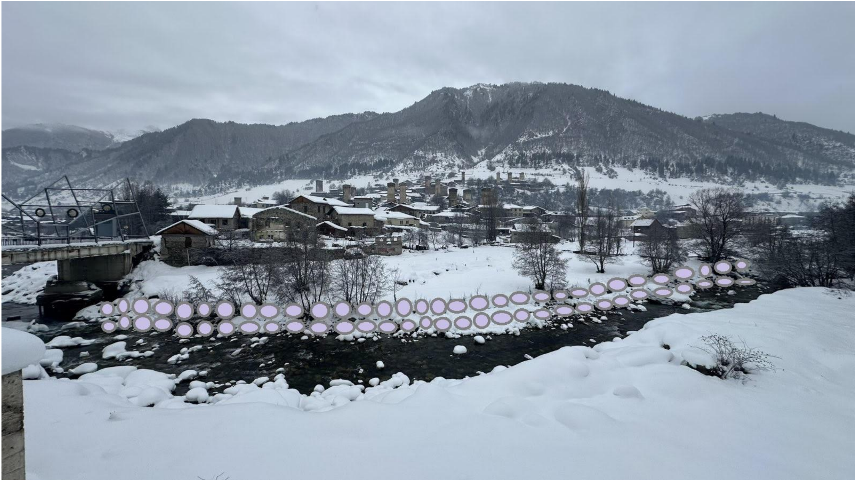
ფიგურა 5.2 მარჯვენა სანაპიროს პირველი სექციის ვიზუალიზაცია, სადაც დაგეგმილია SCS-4.1 ფლეთილი ლოდები ხრეშის სამირკველით/საგებით
